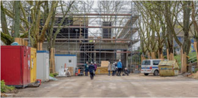
Zu Beginn der Bauphase stellte sich heraus, dass der Untergrund überarbeitet werden musste. Dies geschah im Dezember 2021 im sogenannten „Rüttelstopfverfahren“. Dazu gehören auch die riesigen „L-Steine“, die jetzt noch auf der Laufbahn der Sportanlage liegen und die den Bau stützen sollen.
